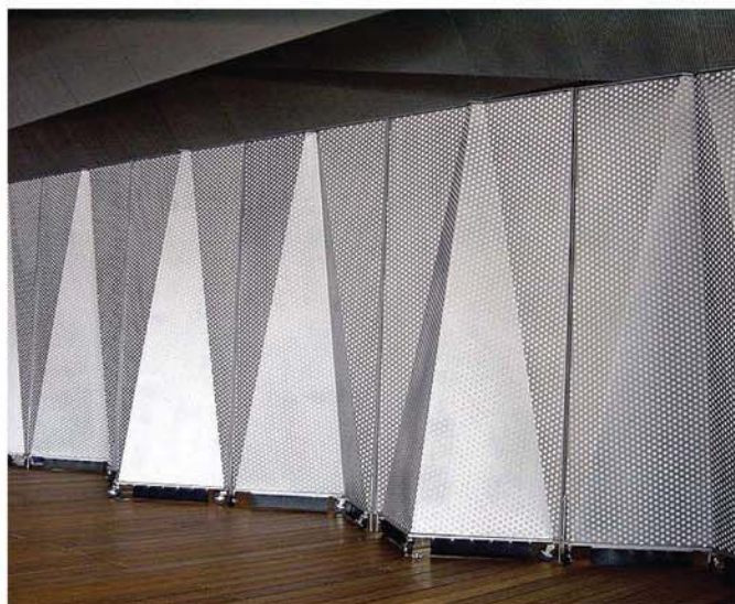
Εσωτερικά διαχωριστικά στοιχεία από διάτρητα και διπλωμένα μεταλλικά φύλλα. Yokohama International Port Terminal. Αρχιτέκτονες: Foreign Office Architects
