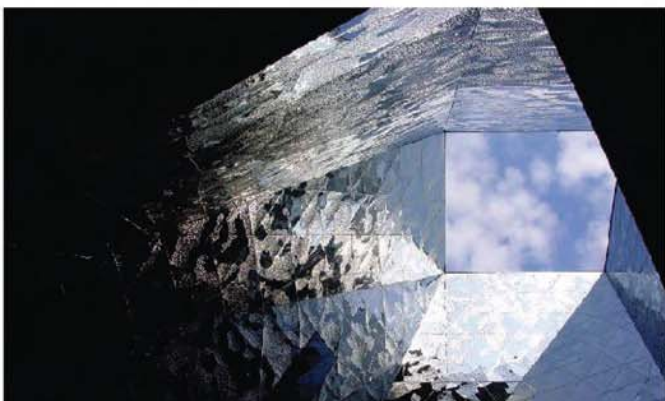
Επένδυση των όψεων αιθρίου με γυαλιστερά ανοξείδωτα φύλλα ψηφιακά επεξεργασμένα με ανάγλυφα σχέδια. Edificio Forum, Βαρκελώνη. Αρχιτέκτονες: J. Herzog & P. de Meuron
