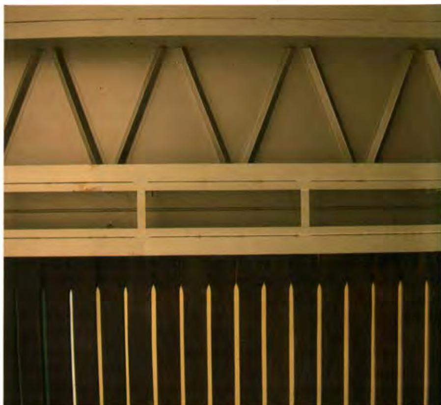
εκδοχή του «αεριζόμενου δώματος» και πετυχαίνει έτσι άνετες συνθήκες διαβίωσης σε μια δύσκολη κλιματική περιοχή του κόσμου. Η άμεση αυτή σχέση του κτιρίου με τα κλιματικά δεδομένα αντικατοπτρίζεται στον σχεδιασμό ολόκληρης της κατασκευής και εικονίζεται ειδικά ως χαρακτηριστικό στοιχείο της όψης. Ο μεταλλικός κατασκευαστικός σκελετός αποτελείται από διπλωμένα μεταλλικά φύλλα που σχηματίζουν δύο υποστηλώματα σε μορφή Π.
